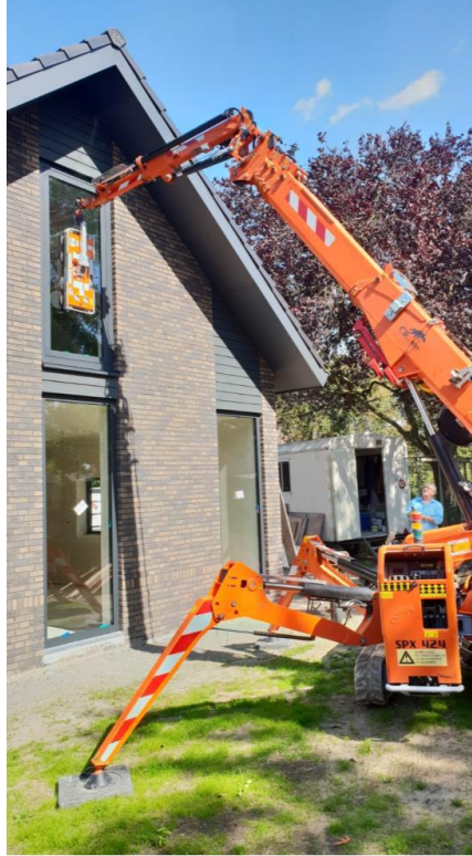
Χαμηλό σε βάρος για τοποθέτηση γυαλιού με τη χρήση μίνι γερανού.
