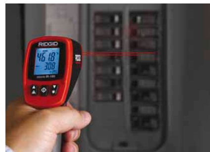
Έλεγχος ασφαλειών ή ασφαλειοδιακοπών για υπερθέρμανση, που μπορεί να προκληθεί από υπερφορτωμένα κυκλώματα
