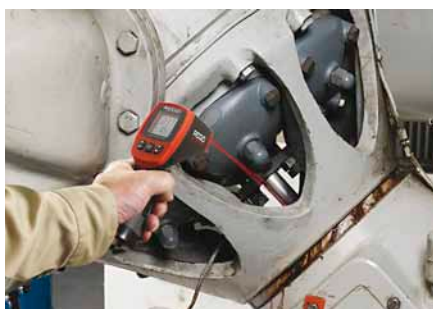
Διαγνωστικός έλεγχος θερμοκρασίας των φθαρμένων εξαρτημάτων για την προληπτική συντήρηση της εγκατάστασης
